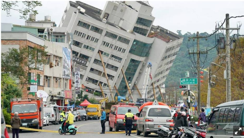
Das Yuntsui Building in Hualien steht nach einem schweren Erdbeben an der Ostküste Tawians schief
