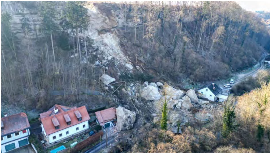
Felssturz in Steyr 2023
