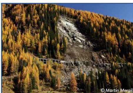
Felsgleitung zerstörte Lawinengalerie, Osttirol, 2013 © Martin Mergili
