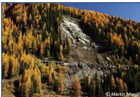
Felsgleitung zerstörte Lawinengalerie, Osttirol, 2013 © Martin Mergili
